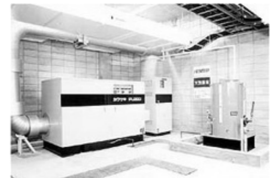
国産初のガスタービン発電設備 「カワサキPU200」(1976年)
