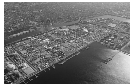
大阪工場全景
